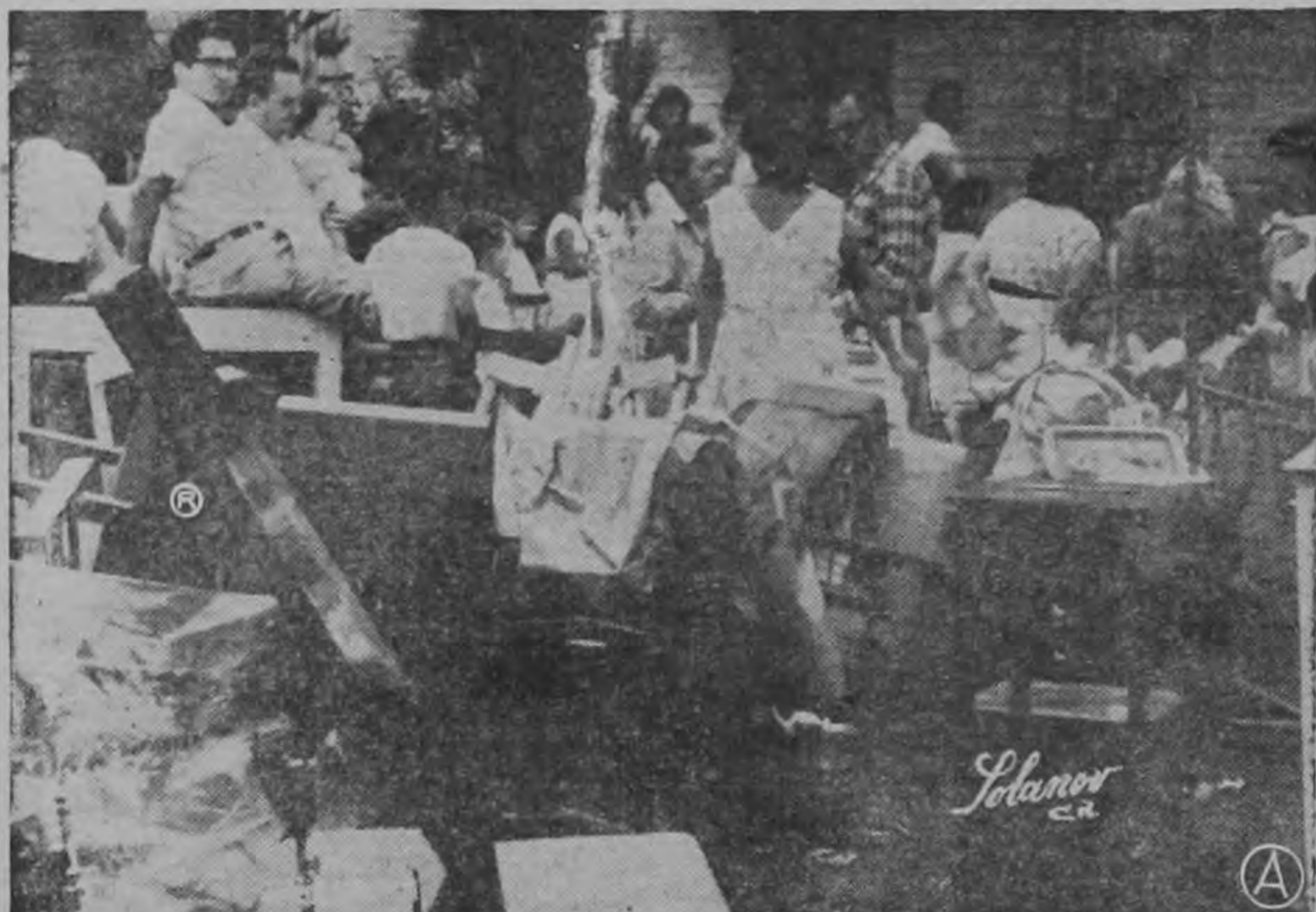
OBSTRUCCION TOTAL. —Grandes dificultades sufrieron los bomberos y las autoridades por la enorme cantidad de curiosos y porque los vecinos tiraron todo en las estrechas calles. Agravó la dificultad para combatir el fuego el hecho de que no había agua. (Foto SOLANOV)
